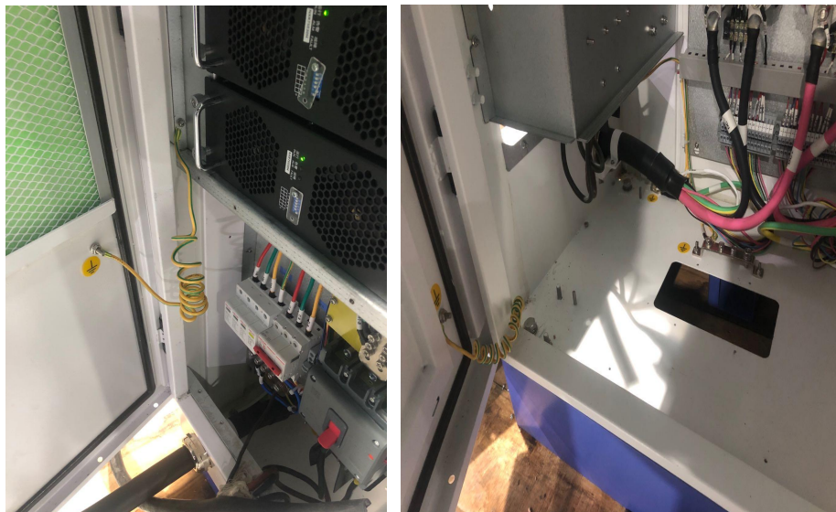
图 3-3 检查接地螺柱的螺帽是否松动
