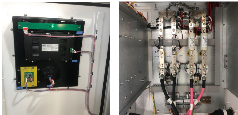
图 3-7 检查充电连接线及缠绕管的老化、磨损情况
