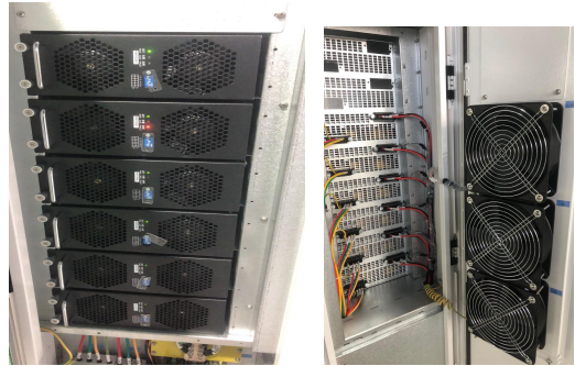
图 3-2 打开侧门检查进出风口积尘
